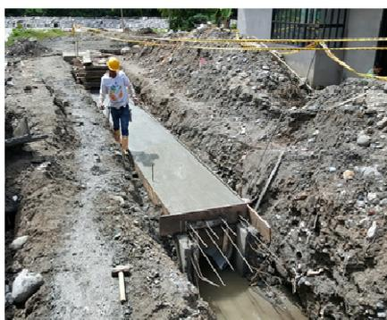
Construcción cárcamo protección tubería de 24"
